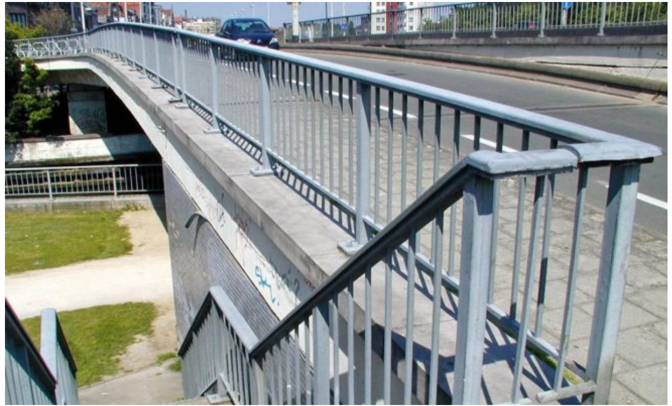
Regalvanisert gjerde, utført med ZINGA. Ghent, Belgien
