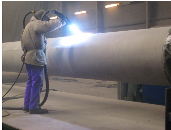
Metallisering (Termisk sprutning)
