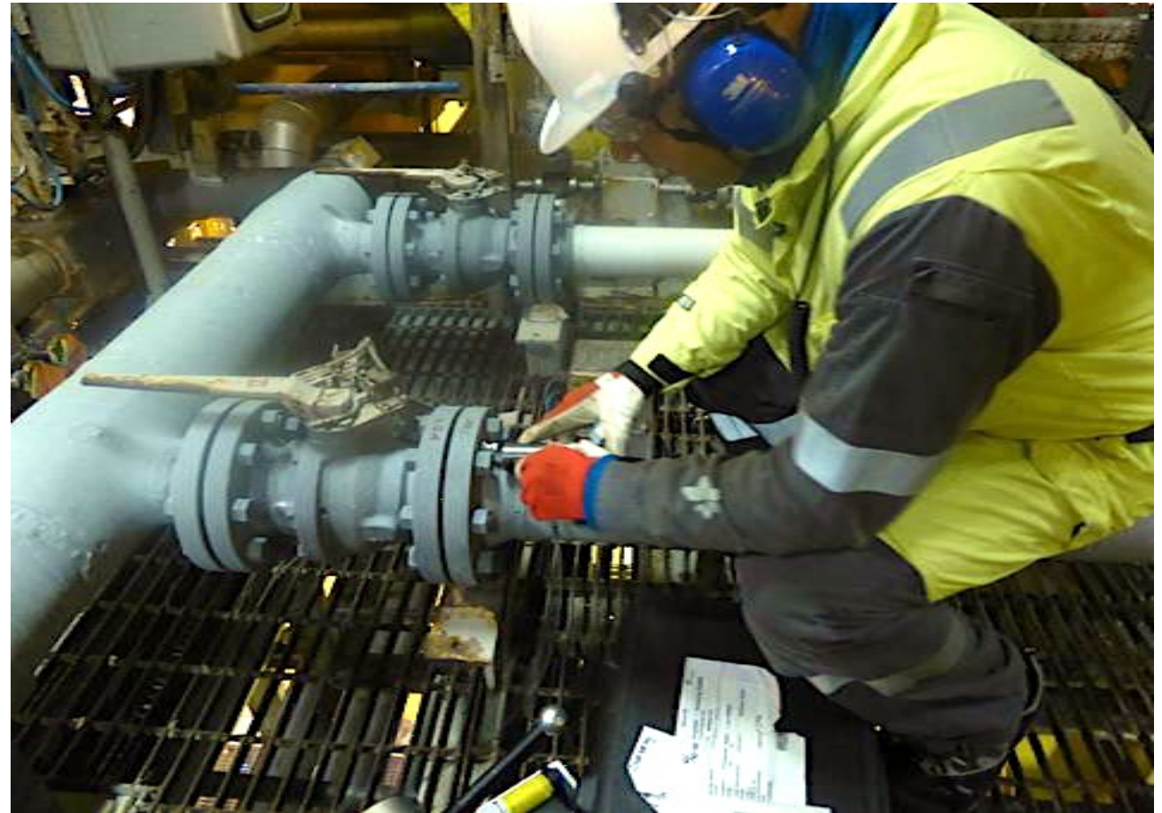
Vedlikehold på boreplattform i Nordsjøen.
